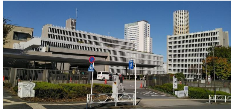
目黒区役所、駒沢通り側から撮影。駅側から入るかたの方が多くいでしょうか。
