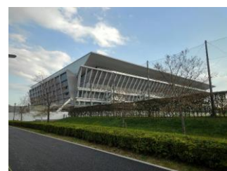
水泳会場。工事中で中は入れず
